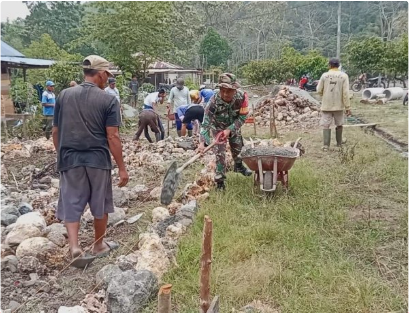
Gotong royong bangun pondasi rumah warga
